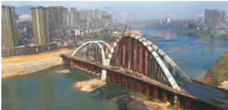
11月29日上午，随着最后一节大型钢构件精准就位，南平建瓯市三江口大桥钢拱成功合龙。
